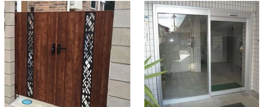
門扉・自動ドア 新設工事
