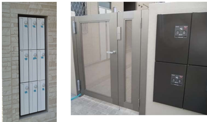
ポスト・宅配ボックス 設置工事
